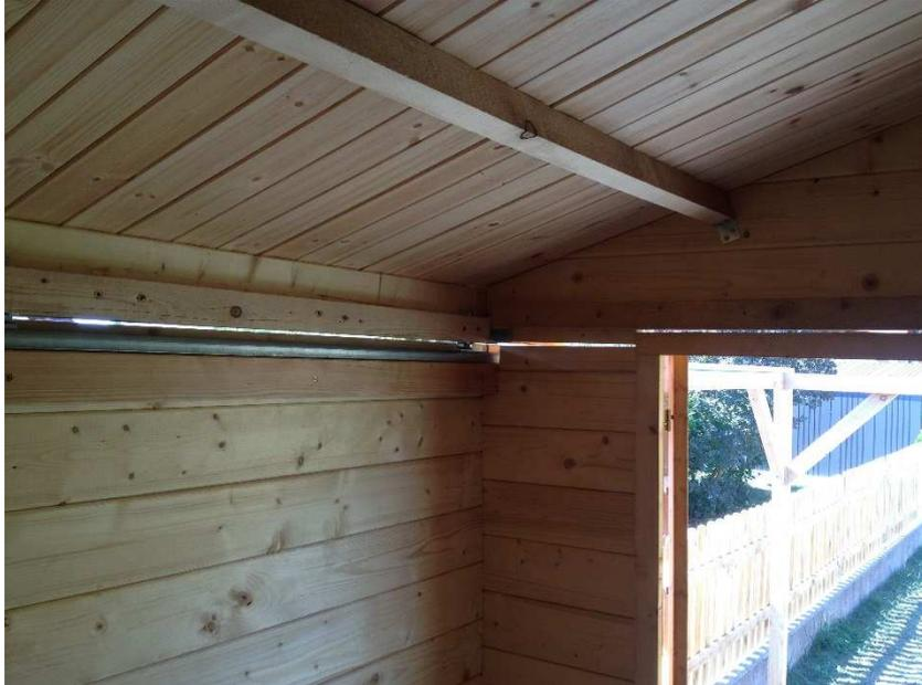
Die vorderen und hinteren Wandbohlen wurden im Bereich der Laufschiene mit etwas Spiel geteilt. Ebenso wurde eine großzügige Aussparung oberhalb des Türrahmens freigelassen, da sich das Holz über das Jahr recht stark ausdehnt und zusammenzieht.
