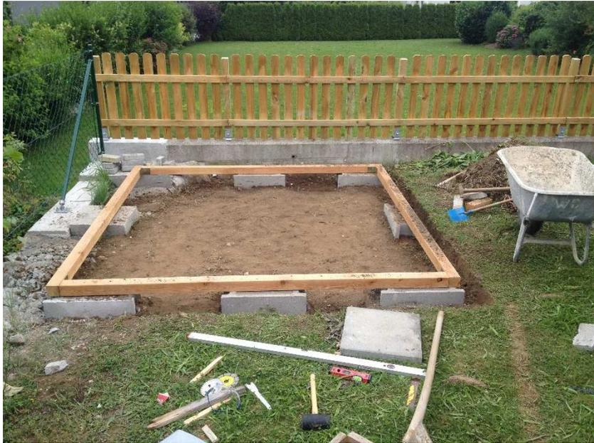
Jetzt kam der Aushub für das Säulenfundament dran, auf der später die Montierung sitzen wird. Es sollte Platz für etwa  $1\text{m}^3$  Beton sein, damit sie fest und stabil steht. Zum Glück haben wir einen Lehmboden, so musste der Aushub nicht gestützt werden.
