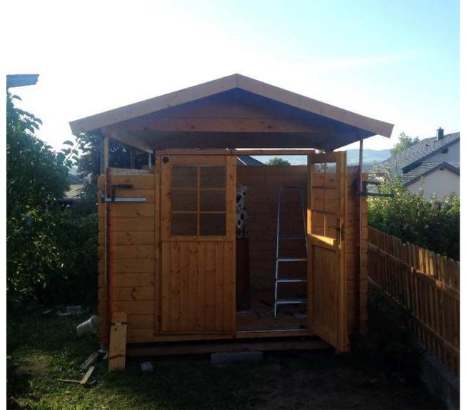
Jetzt konnten wir die Aussparungen und Durchführungen für die Balken und Laufschienen, auf denen das Dach später rollen soll bearbeiten.
